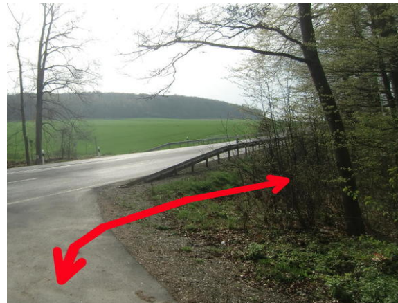
Bild 2: Am Ende des Forstweges von Obermeiser kommend: Beginn des Lückenschlusses entlang der B 7.
