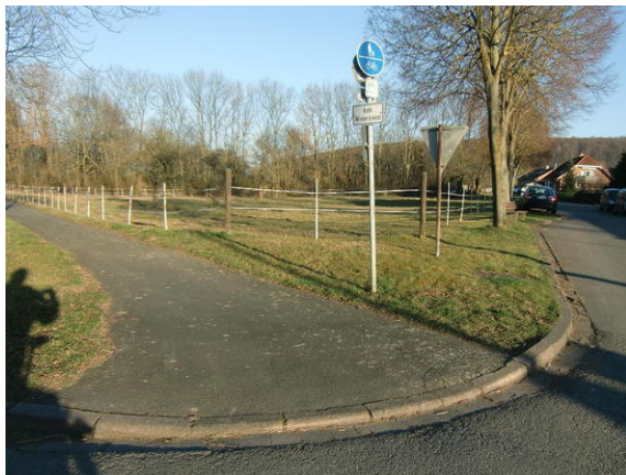
Bild 3: Bordstein ohne Absenkung
