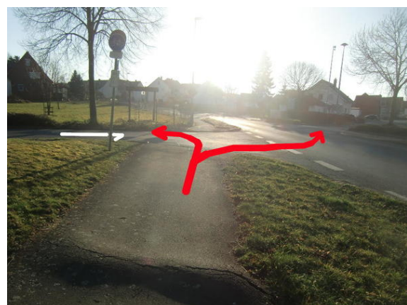
Bild 4: vorne der Wurzelaufbruch, hinten die fehlende Haltelinie für KFZ
