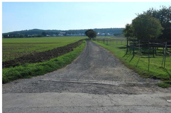
Bild 4: Östliches Maßnahmenende nördlich Mönchehof: Entwässerungsrinne als Sturzgefahr.
