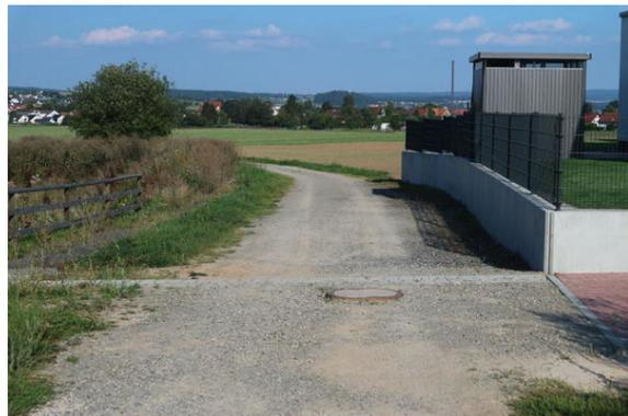
Bild 2: Schotterstrecke Höhe Neubaugebiet: Durch hervorstechende Elemente im Vordergrund besteht Sturzgefahr.
