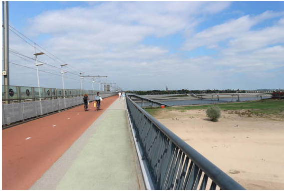
Bild 3: Mit der neuen Radbrücke wurde eine schnelle Direktverbindung von Nijmegen-Lent in Richtung Stadtmitte und Hauptbahnhof geschaffen. Die Brückenstrecke ist Teil der 15 km langen Radschnellverbindung des RijnWaalpads zwischen Nijmegen und Arnhem. Die Radfahrbahn des 1900 m langen Brückenbauwerks dürfte eine Breite von etwa 4 m besitzen. Für Fußgänger gibt es auf dem Bauwerk in großen Teilen noch einen knapp 2 m breiten Gehweg.
