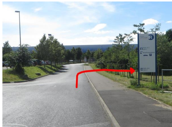
Bild 2: Blick von der George-Stephenson-Straße auf die auszubauende Strecke. Vorne ein abzusenkendes Hochbord (Bild Herbert Iba 2016).
