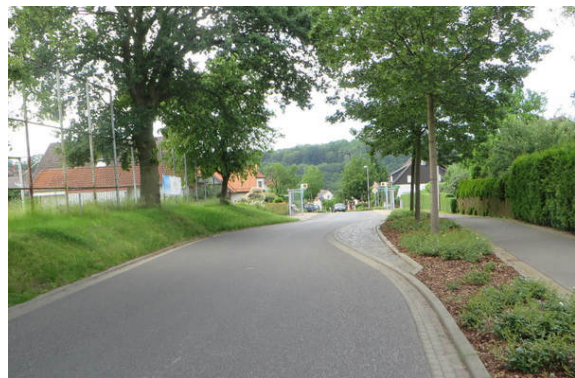
Bild 2: Blick talwärts auf die Fahrbahnverschwenkung
