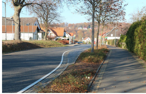
Bild 4: Baulicher Bypass ohne Baumfällung wohl nicht möglich. Das wäre aber die sicherste Lösung.
