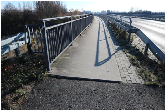
Bild 3: Der hohe Absatz am nördlichen Übergang der Autobahnbrücke. Er sollte angeglichen werden. Südlich der Brücke holpert es am Übergang etwas weniger (allerdings auch noch).
