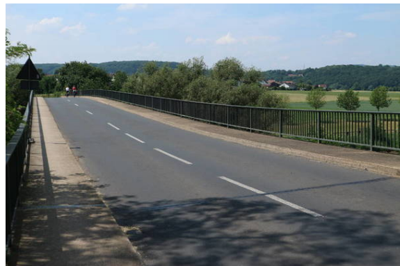
Bild 2: K 16 auf der Brücke. Hier mal mit wenig Verkehr.
