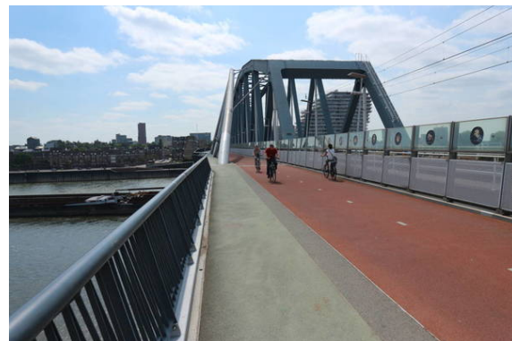
Bild 2: Bei Geo 51.8543 5.8579: Längste Fahrradbrücke der Niederlande? In Nijmegen queren im Abstand von 5,5 km zwei Straßenbrücken mit RVA den Rhein (hier Waal genannt). Dazwischen liegt eine große Eisenbahnbrücke. Im Rahmen des Projekt RijnWaalPad wurde an diese Brücke eine 1900 m lange Fahrrad- und Fußgängerbrücke ("De Snelbinder") angebaut (Video zum RijnWaalpad: https://youtu.be/XBDzPK18C-s ).
