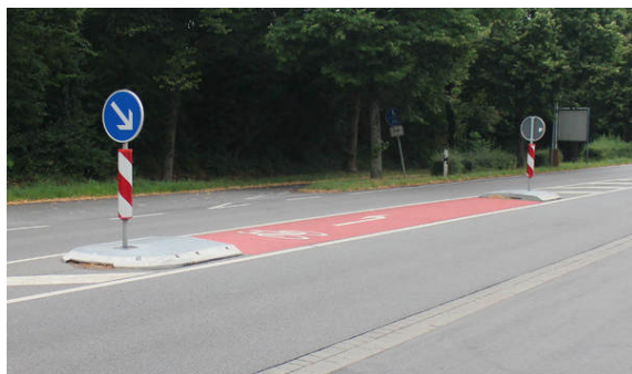
Bild 3: B 3 Heppenheim Bergstraße: Beispiel für eine nachträglich hergestellte längliche Mittelinsel aus Fertigteilen. Der RV durchquert die aufgeweitete Mittelinsel im spitzen Winkel. Bei Bedarf kann in der Insel gestoppt werden (Bild: Dirk Schmidt).
