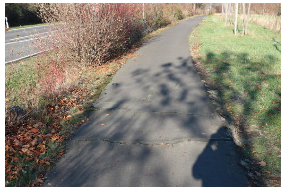
Bild 2: ein paar der vielen Wurzelaufbrüche, die mit Stand 2020 hoffentlich beseitigt wurden.
