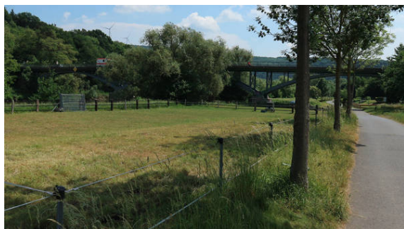
Bild 3: Blick vom R1 auf das Bauwerk: durchaus ein größeres Brückenbauwerk.
