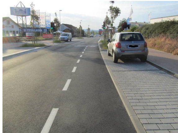
Bild 2: Der Schutzstreifen auf dem Ostring verläuft in der gefährlichen "Autotürenzone". Dazu kommen noch höhere RV-Geschwindigkeiten, da der Schutzstreifen talwärts markiert wurde.
