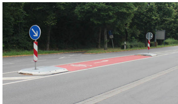
Bild 4: B 3 Heppenheim Bergstraße: Beispiel für eine nachträglich hergestellte, längliche Mittelinsel aus Fertigteilen. Der RV durchquert die aufgeweitete Mittelinsel im spitzen Winkel. Bei Bedarf kann in der Insel gestoppt werden (Bild: Dirk Schmidt).
