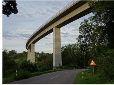
Bild 4: Blick auf das Körschtalviadukt bei Stuttgart mit ähnlichen Abmessungen wie die Hochbrücke an der A44. Hier wurde nachträglich der Serviceweg in eine RVA ausgebaut (Bild: Swen Schneider 09-2019).
