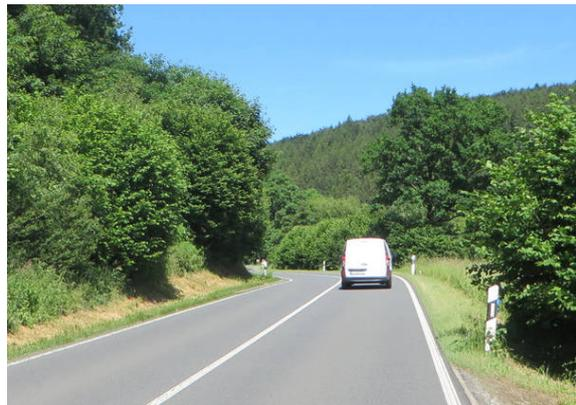
Bild 2: Schwer einsehbare L3237. Hier fehlt rechts eine str.begl. RVA.
