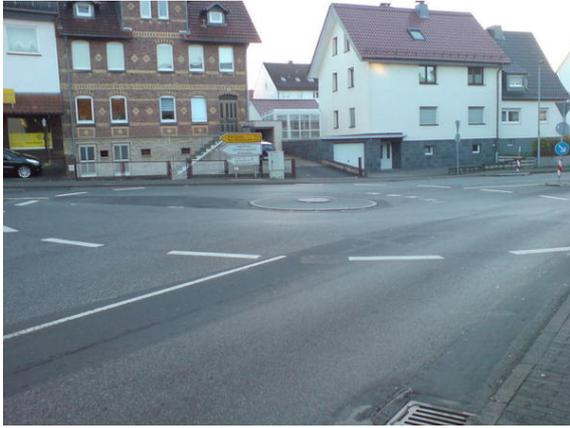
Bild 3: Die ohnehin kleine Mittelinsel des Kreisels ist schlecht erkennbar, da die äußere, weiße Randmarkierung weitgehend abgefahren ist. Bild: 11-2018
