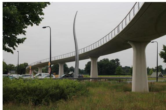
Bild 2: Beispiel: Radbrücke NL über die Auke Vleerstraat in Enschede: überbrückte Länge von 280 m, Baukosten 1,4 Mio in 2011, Video zur Brücke: <http://vimeo.com/55006329>. Es besitzt allerdings keine Separation RV / FV. Dafür ist der Brückenquerschnitt zu klein. Spannweite für komplett über die Fulda allerdings nicht ausreichend (Pfeiler im Wasser notwendig bzw. andere Brückenkonstruktion notwendig).
