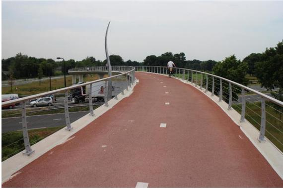
Bild 3: Auf dem Bauwerk: 4 m breite Fahrbahn, allerdings recht niedriges Brückengeländer (wohl keine 1,3 m, wie es in Deutschland Pflicht ist). Details zu dieser Brücke siehe auch Anlage "Handbuch System Radverkehr" -> Abschnitt "Brücken" bzw. oben verlinktes PDF. In Sandershausen wäre allerdings eine Separation RV / FV wichtig.
