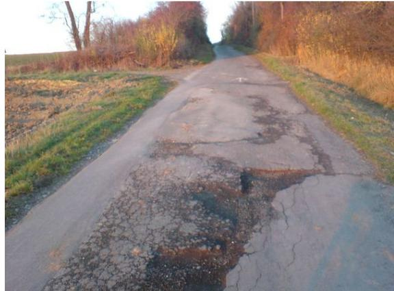
Bild 2: schadhafte Asphaltdecke mit Löchern im Detail
