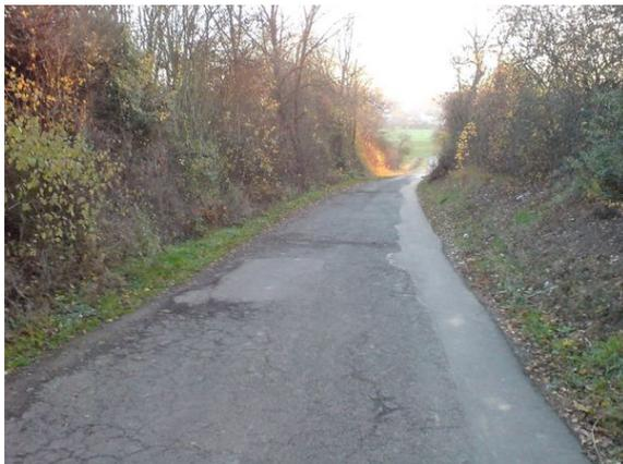
Bild 3: schadhafte Asphaltdecke von oben gesehen.
