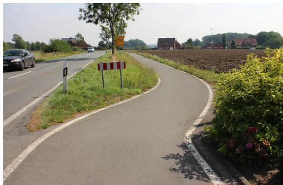
Bild 4: Münsterland: RVA-Verschwenkung mit Reflektor und Fahrbahnbegrenzungslinien.
