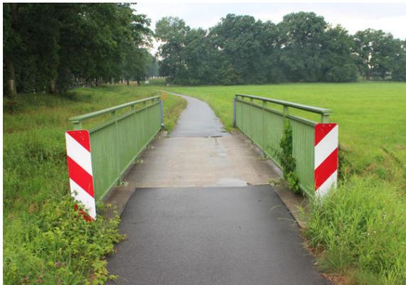
Bild 3: RVA Beeskow – Krügersdorf entlang der B246: Vorbildliche Absicherung der Geländerstöße. des grün „getarnten“ Brückengeländers
