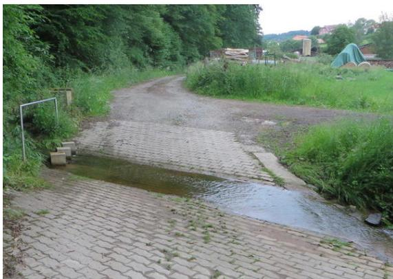
Bild 3: Sturzgefahr für Radfahrer besteht im Furtbereich durch rutschigen Algenbewuchs und Schlammablagerungen. Die Herstellung einer Fußgänger- und Radfahrerbrücke ist aus Sicherheitsgründen sinnvoll.
