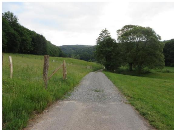
Bild 2: Nach einem Drittel der Strecke von Eiterhagen nach Wattenbach ändert sich die Oberflächenqualität erheblich: anfangs noch asphaltiert, führt der Wirtschaftsweg mit einer Schotterdecke bis Wattenbach.
