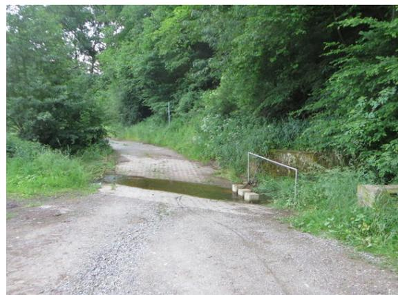
Bild 2: Südlich des gleichnamigen Dorfs quert der Wattenbach in einer baulich mit Betonsteinen angelegten Furt den von Radfahrern in Richtung Eiterhagen genutzten Wirtschaftsweg. Fußgänger sollen die eingebauten Trittsteine und das Geländer zum Überqueren nutzen. Aber Radfahrer ...?
