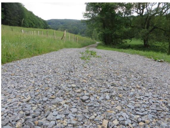
Bild 3: Streckenweise besitzt der Weg eine Deckschicht aus grobem, unverdichtetem Kalkschotter, der mit dem Fahrrad nur unkomfortabel befahrbar ist.
