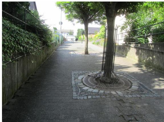
Bild 2: In der nördlichen Zufahrt zur Unterführung stehen Bäume im Verkehrsraum. Ferner ist eine Oberflächenanierung notwendig.
