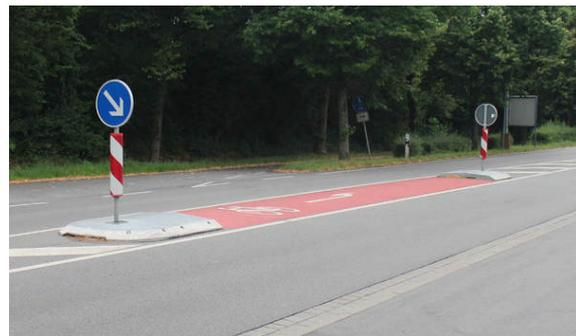
Bild 2: B 3 Heppenheim Bergstraße: Beispiel für eine nachträglich hergestellte längliche Mittelinsel aus Fertigteilen. Der RV durchquert die aufgeweitete Mittelinsel im spitzen Winkel. Bei Bedarf kann in der Insel gestoppt werden (Bild: Dirk Schmidt).
