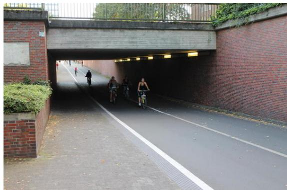
Bild 2: grundlegendes Beispiel für sozial sichere Unterführung: Münster - Unterführung Mauritztor: Das gerade angelegte und damit sozial sichere Bauwerk besitzt getrennte Bereiche für den RV und FV (mit taktiler Trennung).
