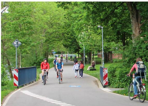
Bild 3: Dreisamferweg Freiburg im Breisgau: Vorbildliche Absicherung von Geländerstößen
