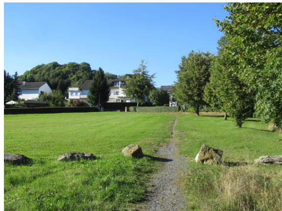
Bild 2: Blick bergauf zur Ludwig-Mueller-Str., vorne die gefährliche Steinsperre (Maßnahme Steinsperre siehe ZIE_29)
