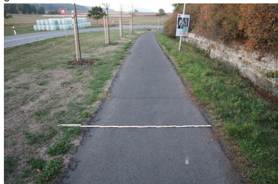
Bild 4: älterer Asphaltweg vor Bahnbrücke. Die Strecke besaß hier wohl mal eine Breite von 2 m. Heute noch real nutzbare Breite von 1,8 m.
