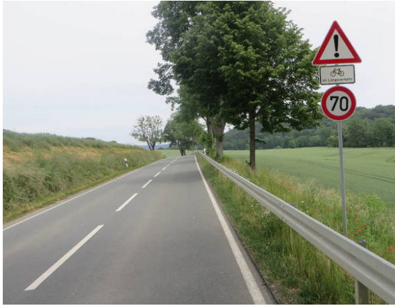
Bild 3: Positiv: Tempo 70 und Hinweis "Achtung RV im Längsverkehr". Allerdings ist auch an dieser unübersichtlichen Stelle ein rechtskonformes, verkehrssicheres Überholen des RV durch KFZ nicht möglich.
