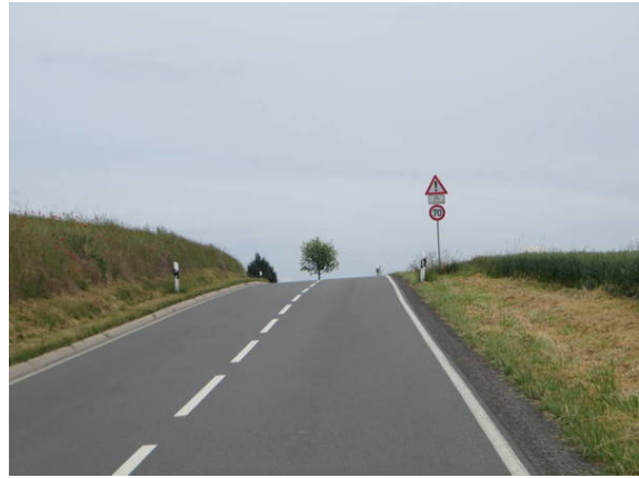
Bild 4: Positiv auch hier: Tempo 70 und Hinweis "Achtung RV im Längsverkehr". Allerdings ist auch an dieser unübersichtlichen Kuppe ein rechtskonformes, verkehrssicheres Überholen des RV durch KFZ nicht möglich.
