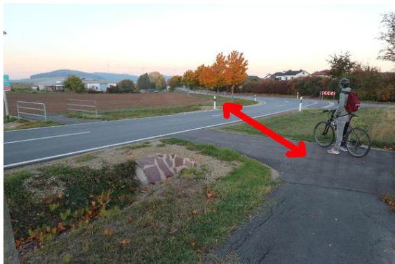
Bild 3: Blick auf die alte, nicht bedarfsgerechte Querung. hier ist eine neue Querung in Schräglage notwendig (am besten mit Mittelinsel).
