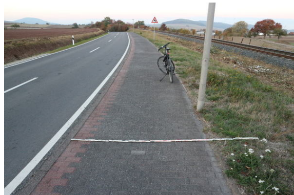
Bild 2: Blick Bahnhof richtung Oberelsungen: Der Bestandsweg misst inklusive Sicherheitsraum zur Fahrbahn gerade einmal 2 m.
