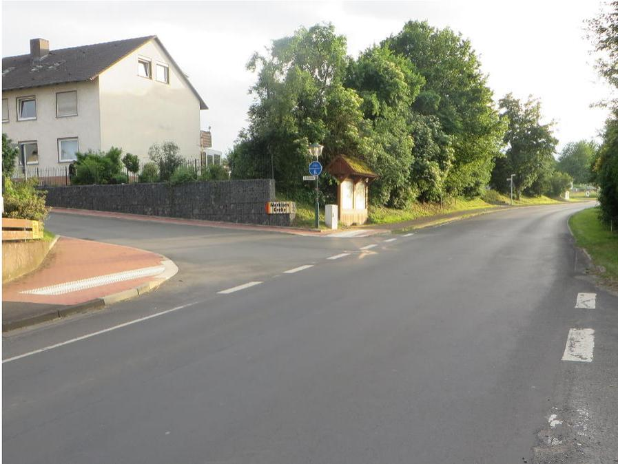
**Abbildung 2.1** Überquerungssituation auf der Ortsdurchfahrt K 31 in Heckershausen: Radfahrer müssen in Richtung Weimar ungesichert von der Fahrbahn aus die zu schmale, aber benutzungspflichtige linke Radverkehrsanlage erreichen
