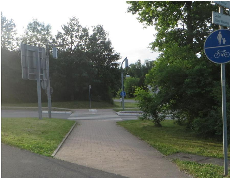
**Abbildung 3.4** Inakzeptable Radverkehrsführung am Kreisverkehr in Weimar über die K 29: eine Kombination von benutzungspflichtiger Radverkehrsanlage und Fußgängerüberweg ohne Radfahrfurt ist nicht nur unzulässig, sondern konfliktträchtig
