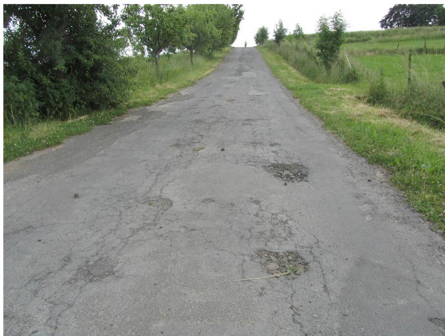
**Abbildung 2.2** Schadhafte Asphaltdecke auf der Ortsverbindung Weimar - Fürstenwald.
