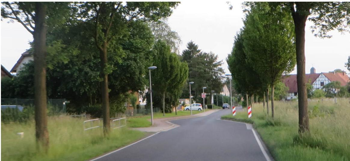
**Abbildung 4.2** für den RV zum Teil problematische Fahrbahnverschwenkung am Ortseingang der K 39 in Hohenkirchen.
