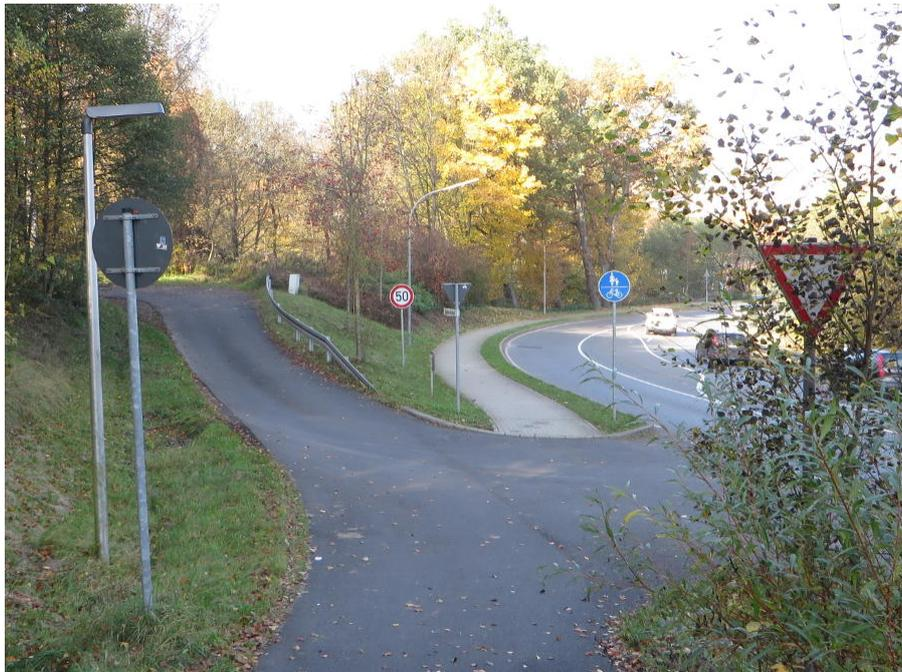
**Abbildung 3.1** Die Radverkehrsanlage an einer Hauszufahrt an der B 3 im Schocketal: für Radfahrer besteht eine Wartepflicht gegenüber dem ein- und ausfahrenden Verkehr
