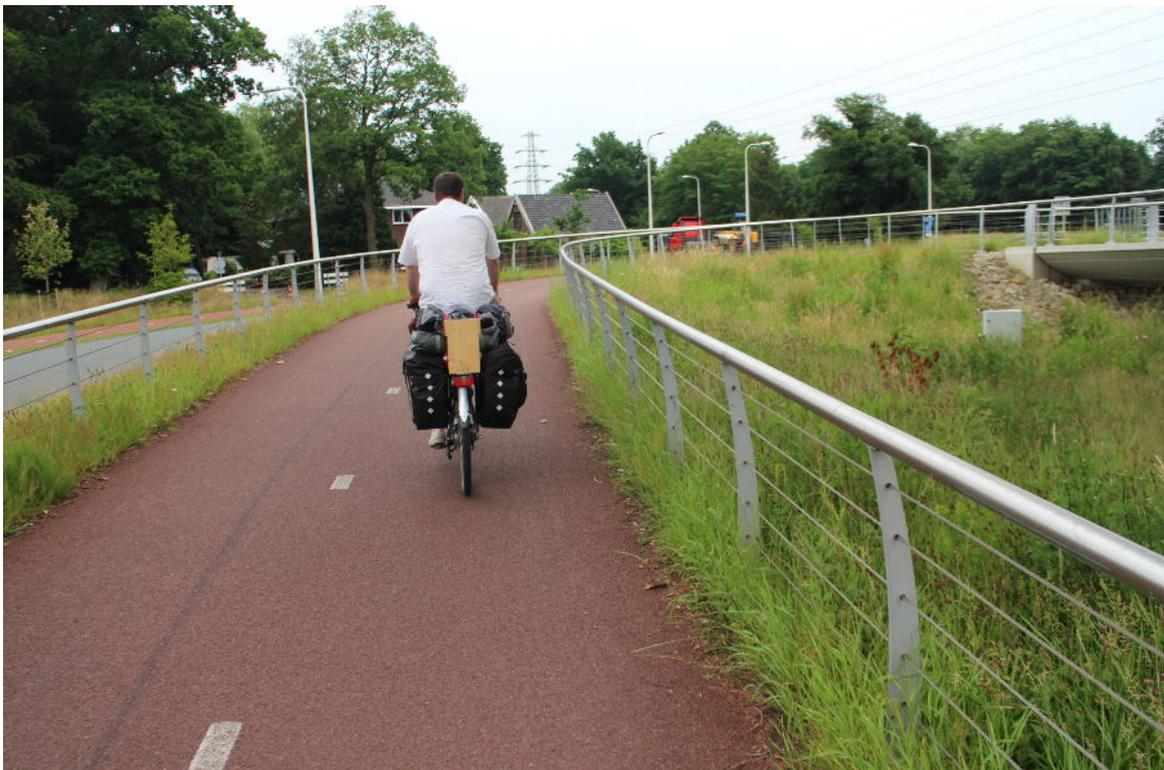
**Abbildung 4.4** Fahrradbrücke Auke Vleerstraat: Rampe auf der Ostseite. Diese wurde als Wendel errichtet. Bild: Dirk Schmidt 06-2015
