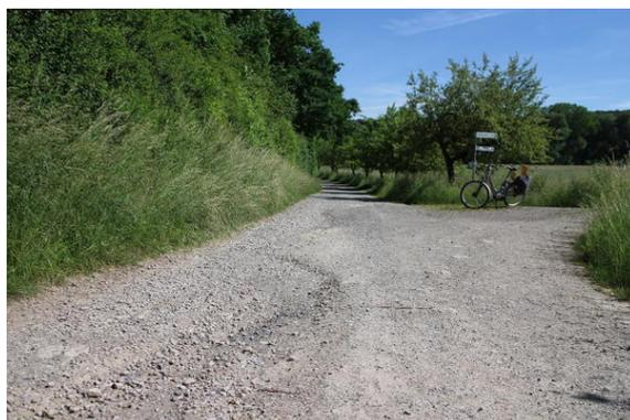
Bild 3: Blick talwärts auf die Schotterdecke mit Auswaschungen mit losem Schotter.
