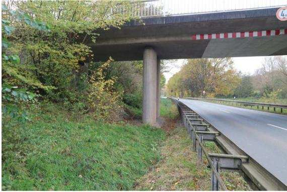
Bild 3: getrennte Fahrrichtungen unter der Brücke (Pfeilder mit Reflektoren absichern, Straßengraben verrohren).
