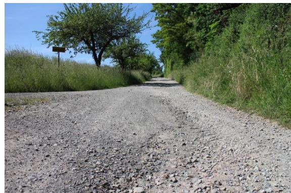
Bild 2: Blick bergwärts auf die Auswaschungen mit losem Schotter.
