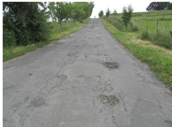
Bild 2: Blick auf die schadhafte Decke.
