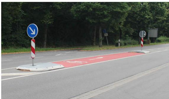
Bild 3: B 3 Heppenheim Bergstraße: Beispiel für eine nachträglich hergestellte längliche Mittelinsel aus Fertigteilen. Der RV durchquert die aufgeweitete Mittelinsel im spitzen Winkel. Bei Bedarf kann in der Insel gestoppt werden (Bild: Dirk Schmidt).
