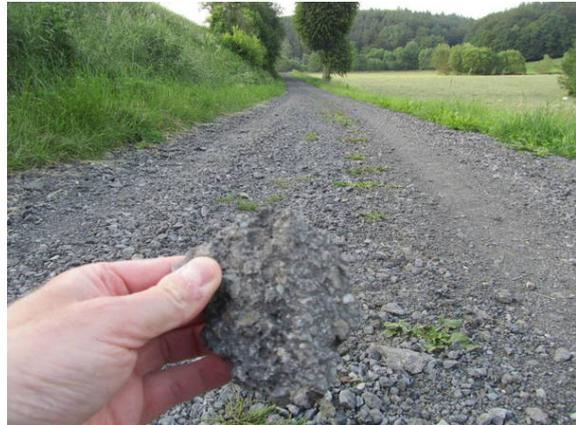
Bild 2: Beispielhafte "Korngröße" der losen Grobschotterdecke. Es besteht vor allem für den ungeübten RV Sturzgefahr!
