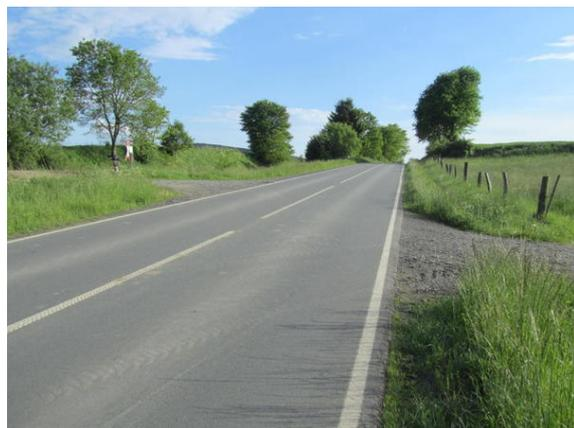
Bild 2: Schwer einsehbare Kuppe auf der L 3220 mit durchgezogener Mittellinie.
