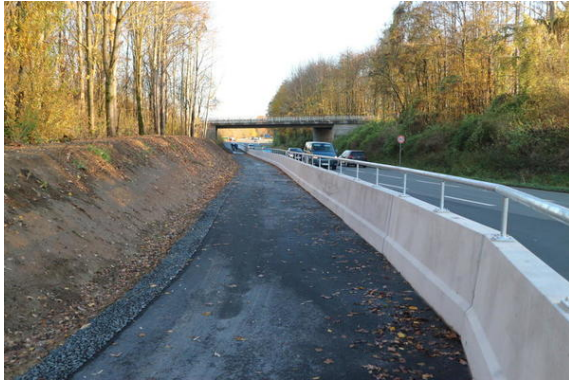
Bild 3: Neue RVA zwischen Elgershausen und Altenritte, die per Bottonbarriere sicher von der KFZ-Fahrbahn getrennt wurde (siehe BAU_9).
