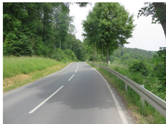
Bild 2: L3211: uneinsichtige Kuppe - trotzdem keine durchgezogene Mittellinie. Schutzplanken nützen vielleicht dem Kraftverkehr, der Radverkehr wird dadurch aber stark gefährdet, da er im Notfall noch nicht einmal mehr in den Grünstreifen ausweichen kann.
