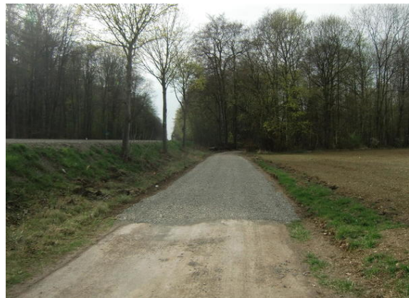
Bild 2: Beginn Schotterstrecke von Obermeiser kommend
