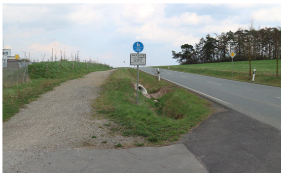
Bild 3: Blick südlicher Maßnahmenbeginn.
