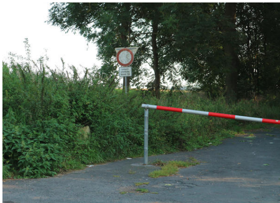
Bild 3: enge Schrankenumfahrung und fehlende RV-Freigabe
