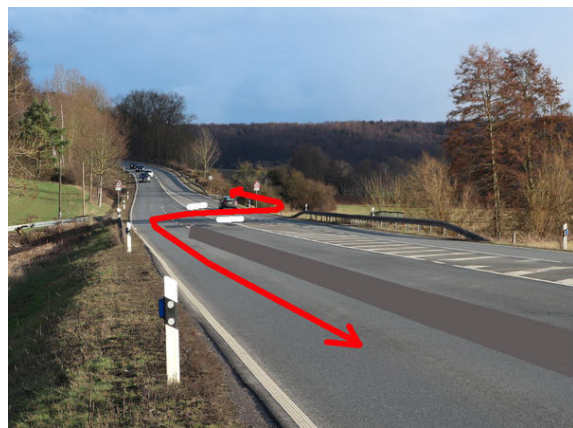
Bild 2: Blick von Wirtschaftsweg mit Zoon in die Maßnahme. Der Übergang wurde schematisch skizziert. aus sicherheitsgründen erfolgte keine weitere Erkundung im Bereich der B 7 (Bild: Dirk Schmidt 03-2019).
