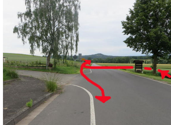
Bild 4: Ende der neuen RVA am Ortseingang Obermeiser: fehlende Querungshilfe (siehe Maßnahme CAL_30)
