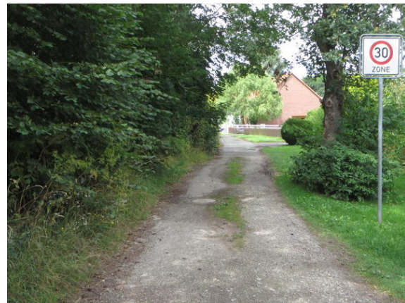
Bild 4: Anschluss des Wirtschaftswegs an die Straße „An dem Kampe“ in Meimbressen
