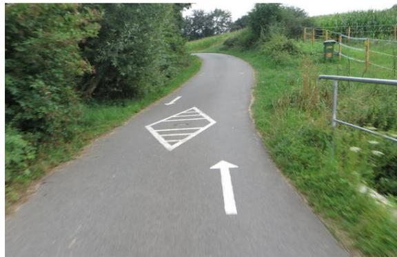
Bild 2: Pfostenstandort mit zu kurzer Keilmarkierung
