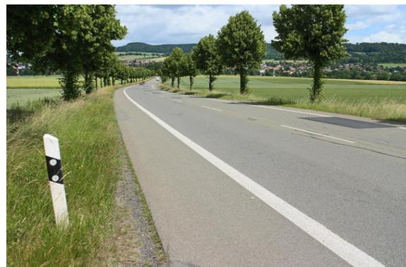
Bild 2: Blick auf die B251 Richtung Ehlen: Würden die beiden Seitenstreifen im südlichen Bereich der Fahrbahn zusammengefasst, könnte ein ausreichend breiter Bereich für eine RVA per Barriere abgetrennt werden.
