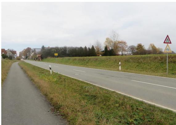
Bild 3: Auf das Radwegende und die Fahrbahnverengung in der Ortseinfahrt wird mit einer amtlichen Beschilderung hingewiesen (positiv).
