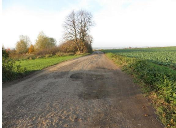
Bild 4: Gut zu erkennen die stark zerstörte Asphalttragschicht des Wirtschaftswegs (alt 2017). Auf dem ca. 850 m langen Wegabschnitt besteht erhebliche Sturzgefahr!
