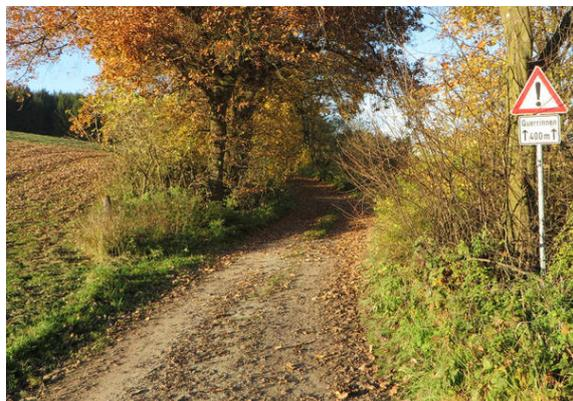
Bild 3: Teilweise ausgewaschener Grobschotterbelag mit mehreren Querrinnen und Grasbewuchs in Fahrbahnmitte.
