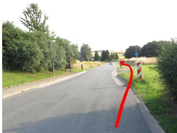
Bild 2: Blick auf die Einengung. Hier könnte die Einengung rechts zurückgebaut werden. Damit wäre hier wahrscheinlich mit Platz für eine Mittelinsel. roter Pfeil: neues RVA-Stück
