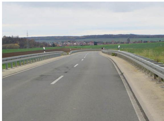
Bild 2: Gefährlich für den RV sind die zum Teil vorhandenen Hochborde mit beidseitigen Leitplanken außerorts. Im Gefahrenfall kann der RV hier noch nicht einmal mehr seitlich in den Grünstreifen ausweichen.
