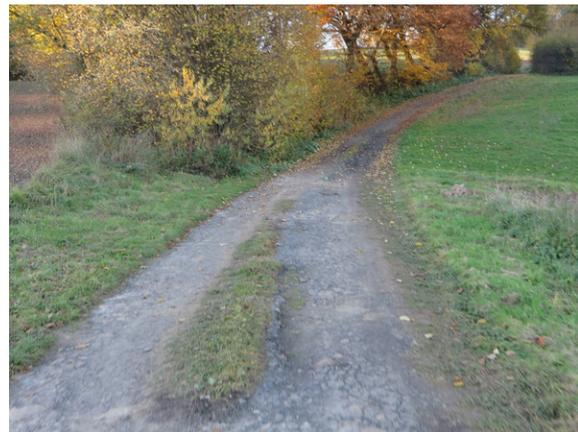
Bild 2: Holprige Altasphaltstrecke im Übergang zu Schotter
