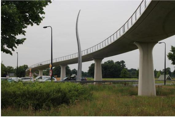
Bild 3: Beispiel: Radbrücke NL über die Auke Vleerstraat in Enschede: überbrückte Länge von 280 m, Baukosten 1,4 Mio in 2011, Video zur Brücke: <http://vimeo.com/55006329>). Es besitzt allerdings keine Separation RV / FV. Dafür ist der Brückenquerschnitt zu klein.
