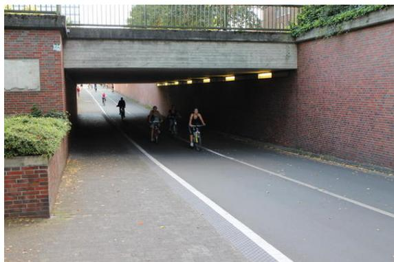
Bild 3: Münster - Unterführung Mauritztor: Das gerade angelegte und damit sozial sichere Bauwerk besitzt getrennte Bereiche für den RV und FV (mit taktlicher Trennung).
