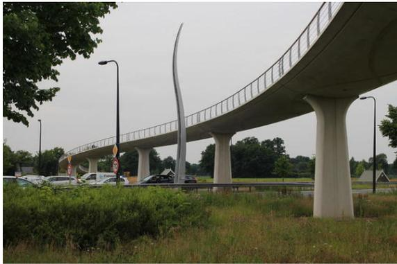
Bild 3: Radbrücke übe die Auke Vleerstraat in Enschede: Das Bauwerk könnte evtl. ein mögliches Vorbild sein (überbrückte Länge von 280 m, Baukosten 1,4 Mio in 2011). Es besitzt allerdings keine Separation RV / FV. Dafür ist der Brückenquerschnitt zu klein.
