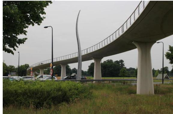
Bild 2: Radbrücke über die Auke Vleerstraat in Enschede: Das Bauwerk könnte evtl. ein mögliches Vorbild sein (Überbrückte Länge von 280 m, Baukosten 1,4 Mio in 2011, Video zur Brücke: <https://vimeo.com/55006329>).
