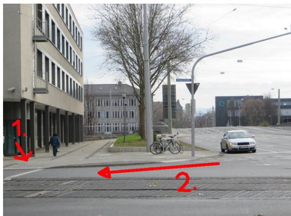
Bild 3: Bei 1. findet sich die weit abgesetzte Radfurt an der LSA. Von 2. kommen rechts abbiegende KFZ, die mit der selben Ampelphase grün haben. Minimum ist hier eine rot markierte Radfurt. Weitgehend vollständige Sicherheit bietet nur eine eigene Ampelphase für den RV und FV (Bild: H. Iba 2016).
