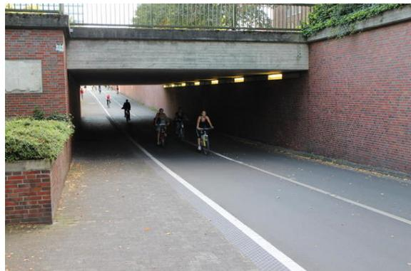
Bild 2: Münster - Unterführung Mauritztor: Das gerade angelegte und damit sozial sichere Bauwerk besitzt getrennte Bereiche für den RV und FV (mit taktiler Trennung). Die Richtungsfahrbahnen für den RV sind aus Sicherheitsgründen noch einmal getrennt.
