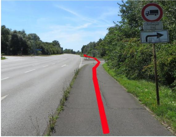
Bild 3: Der in dieser Richtung die Nürnberger Straße querende Radverkehr ist aktuell besonders gefährdet von aus gleicher Richtung kommenden und teils mit hoher Geschwindigkeit rechts einbiegenden KFZ. Die Sichtbeziehungen sind höchst ungenügend. Nur bei fahrbahn-naher Radverkehrsführung sind optimale Sichtfelder herzustellen.
