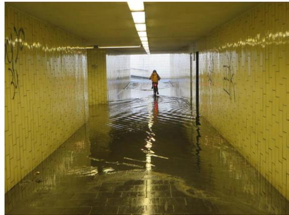
Bild 2: Aktuelle Unterführung mehrere Stunden nach einem Gewitterguss: Das ist nicht nur einfaches Niederschlagswasser, sondern vorne besitzt die Brühe auch noch unappetitliche "Anteile". Kurz nach diesem Gewitterguss stand das Wasser übrigens so hoch, dass eine Querung noch nicht einmal mit dem Fahrrad möglich war (Bild: Herbert Iba 2017).
