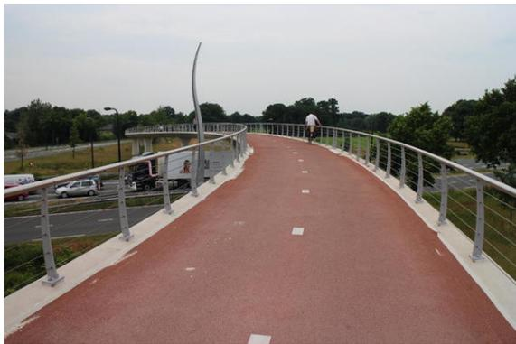
Bild 3: Auf dem Bauwerk: etwa 4 m breite Fahrbahn, allerdings recht niedriges Brückengeländer (wohl keine 1,3 m, wie es in Deutschland Pflicht ist).
