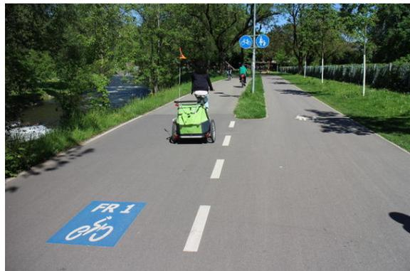
Bild 2: Radvorrangroute FR1 in Freiburg entlang der Dreisam: links 3 m für den RV, rechts 2,5 m für den FV.
