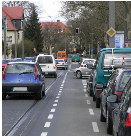
Bild 2: Schutzstreifen talwärts direkt in der Autotürenzone. Es fehlt ein Sicherheitsraum von mindestens 0,75 m Breite zwischen Schutzstreifen und Längsparkern (Bild: Herbert Iba).
