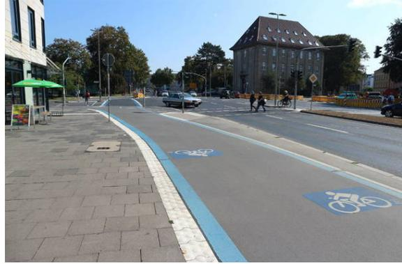
Bild 4: Göttingen - eRaschnellweg: hochwertige Gestaltung mit Asphalt im Seitenraum. Klare Separation RV & FV durch unterschiedliche Oberflächen und klar erkennbare, weiße taktile Formsteine.
