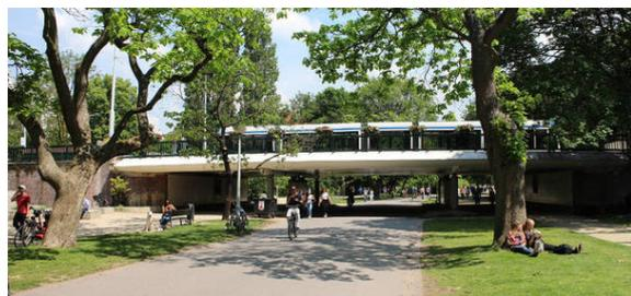
Bild 2: Amsterdam Vondelpark: Eine Hauptverkehrsstraße mit Straßenbahnlinie quert so die Hauptparkachse. Diese Parkachse ist für den Radverkehr gleichzeitig eine wichtige Radialachse in Richtung Stadtmitte. In dieser breiten, einsichtigen Unterführung kommt kein "Engegefühl" auf. Da der Bau im Durchstich einsehbar ist, ist die soziale Sicherheit gewährleistet.
