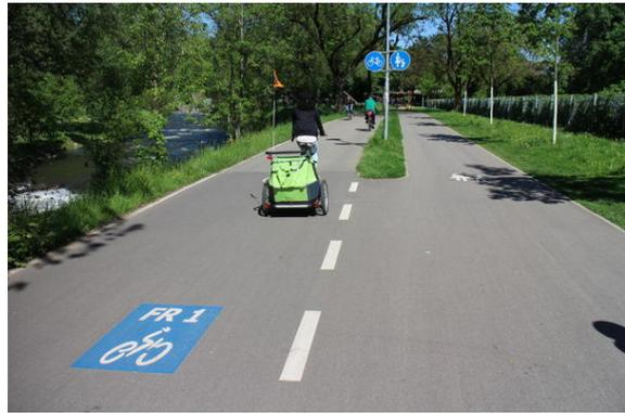
Bild 4: Radvorrangroute FR1 in Freiburg entlang der Dreisam: links 3 m für den RV, rechts 2,5 m für den FV.
