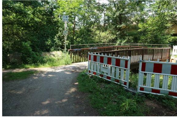
Bild 4: Der vordere Geländerstoß ist hier mal gerade mit Bauzäunen "gesichert". Es fehlen aber auch an dieser Brücke dauerhaft Leitbaken.
