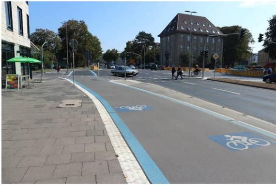
Bild 3: Göttingen - eRaschnellweg: hochwertige Gestaltung mit Asphalt im Seitenraum. klare Separation RV & FV durch unterschiedliche Oberflächen und klar erkennbare, weiße taktile Formsteine bzw. blaue Randmarkierung.
