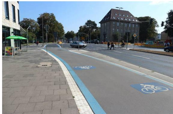
Bild 2: Göttingen - eRaschnellweg: hochwertige Gestaltung mit Asphalt im Seitenraum. klare Separation RV & FV durch unterschiedliche Oberflächen und klar erkennbare, weiße taktile Formsteine bzw. blaue Randmarkierung.
