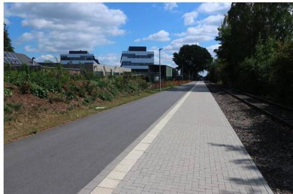
Bild 2: Europa-Radbahn Kleve - Kranenburg: Hier ist die Zuordnung der RV- und FV- Flächen durch Asphalt / Pflaster sowie durch die wichtige taktile Trennung klar erkennbar. weitere Info zur Europa-Radbahn <https://youtu.be/9KTnwB34bhE>
