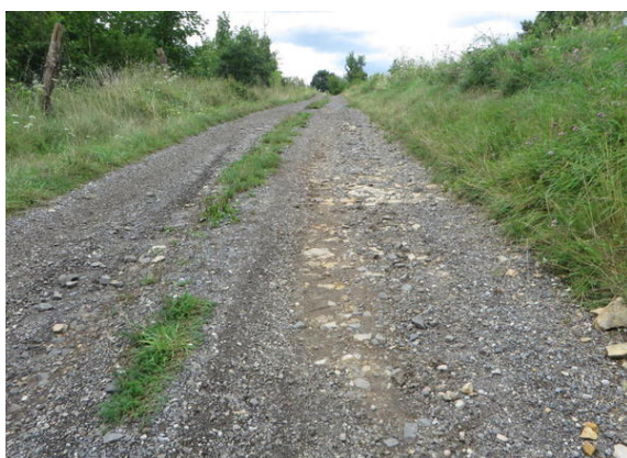
Bild 3: Grobe Schotterdecke im Steigungsabschnitt.
