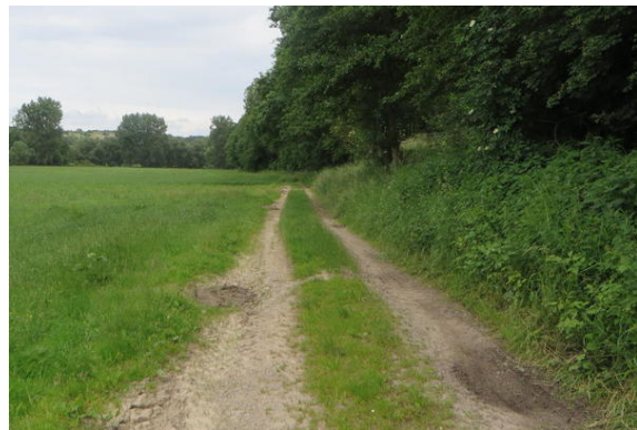
Bild 2: Blickrichtung Haueda: schwer befahrbarer Streckenzustand.
