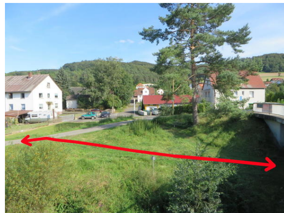
Bild 2: Vorhandener Grasweg unter der Diemelbrücke der L 3220: ist auszubauen
