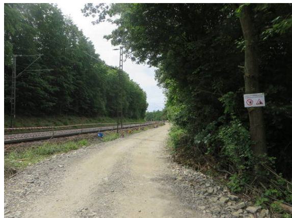
Bild 4: Die derzeitige Baustraße in Haueda kann als Einstieg in die Neubaustrecke einbezogen werden.
