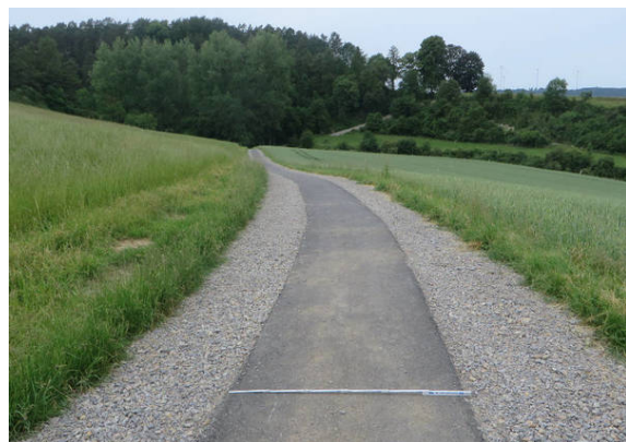
Bild 2: Als Lückenschluss wurde der Schotterweg mit einer 1,2 m breiten Asphaltfahrbahn versehen: es besteht die Gefahr offener Bankette und bei Gegenverkehr des RV muss ein Verkehrsteilnehmer in den Schotter ausweichen. Sturzgefahr durch evtl. offene Bankette.
