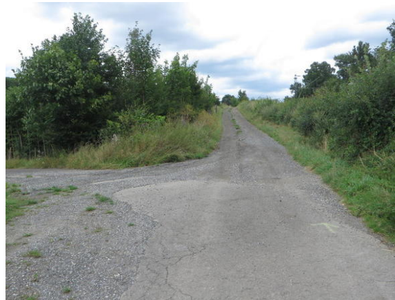
Bild 2: Blick vom unteren Ende des Asphaltwegs auf den geschotterten Steigungsabschnitt.
