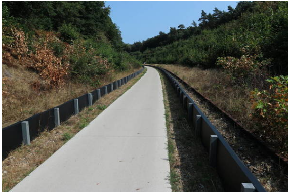
Bild 3: Niederlande: Amphibienschutzanlage am Bahnradweg zwischen Nijmegen und Groesbeek (Lage grob bei Geo 51.7750 5.9059 im Schutzgebiet "De Wolfseberg").
