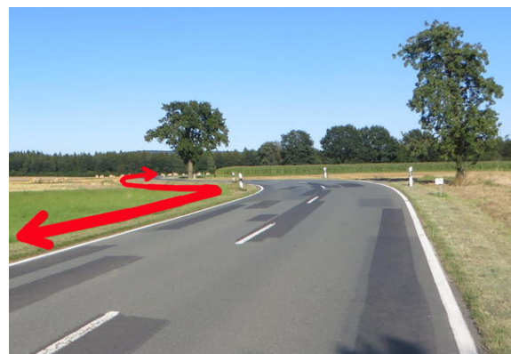
Bild 2: Blick Richtung Gottsbühren etwas östlich Ortsausgang Friedrichsfeld: RVA-Trasse nördlich der Landstraße.
