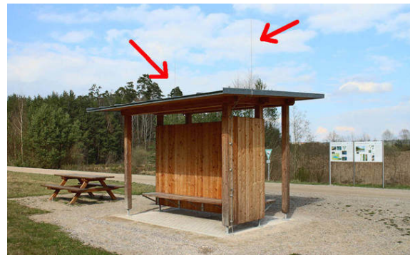
Bild 2: Fränkisches Seenland: Dieser Radwanderrastplatz am Großen Brombachsee besitzt eine blitzschutzsichere Schutzhütte mit Metalldach und zwei Blitzableitern.
