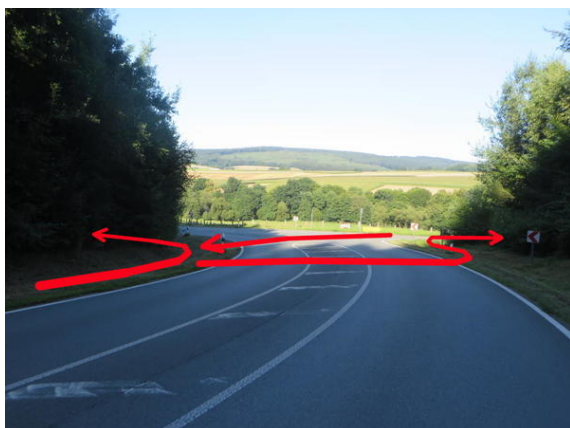
Bild 3: Blick Richtung Gottsbühren: Anbindung K 58 als die neue RVA: Mittelinsel für Fahrt in die K 58.
