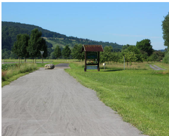
Bild 3: Blick auf die wassergebundene Decke. Zu sehen sind die Fahrspuren im z. T. losen Sand.
