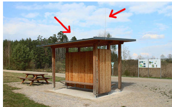
Bild 2: Evtl. optional: Fränkisches Seenland: Dieser Radwanderrastplatz am Großen Brombachsee besitzt eine blitzschutzsichere Schutzhütte mit Metaldach und zwei Blitzableitern.
