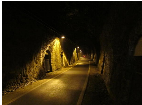
Bild 4: Asphaltfahrbahn im Milseburgtunnel in der Rhön.
