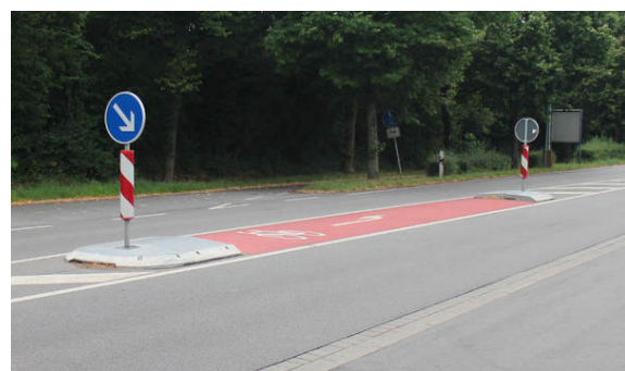
Bild 4: Beispiel Heppenheim / B 3: schmale, langgezogene Mittelinsel mit 1,6 m Breite für die Fahrbahnquerung im spitzen Winkel.
