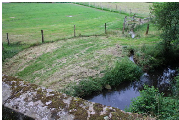
Bild 3: Talblick vom Viadukt: Hier geht es bis zum Wasserspiegel der Holzape sicher 3 bis 4 m abwärts.
