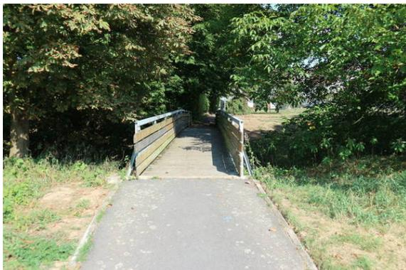
Bild 3: kurzfristig sollten hier die Geländerstöße reflektierend markiert werden.
