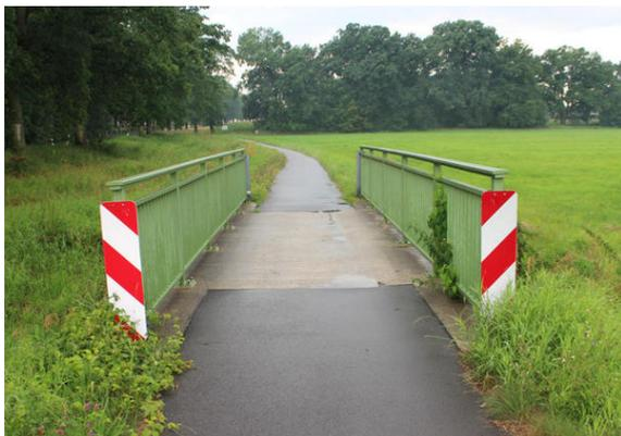
Bild 3: VA Beeskow – Krügersdorf entlang der B246: Vorbildliche Absicherung der Geländerstöße des grün „getarnten“ Brückengeländers.
