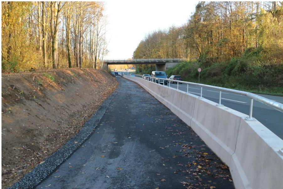
**Abbildung 4.3** Neue, sozial sichere RVA, die per Barriere von der KFZ-Fahrbahn getrennt wurde.
