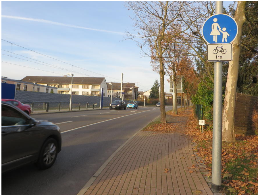
Abbildung 3.1 Radverkehrsführung an der L 3386 am Knoten Nordstraße mit Blick in Richtung Norden: vor wenigen Jahren war dies noch eine benutzungspflichtige Radverkehrsanlage
